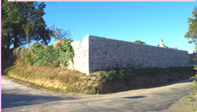
Après : ils l'ont fait en travaillant de 8 h à 13 heures !
