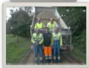
Renforcements de chaussée Charpeau, Varennes, Castres Dourdé
