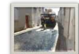
Goudronnage Rue Maubec et Cul de sac
